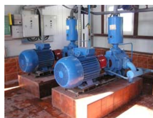
Рис. 2 Силовые установки и щиты управления
